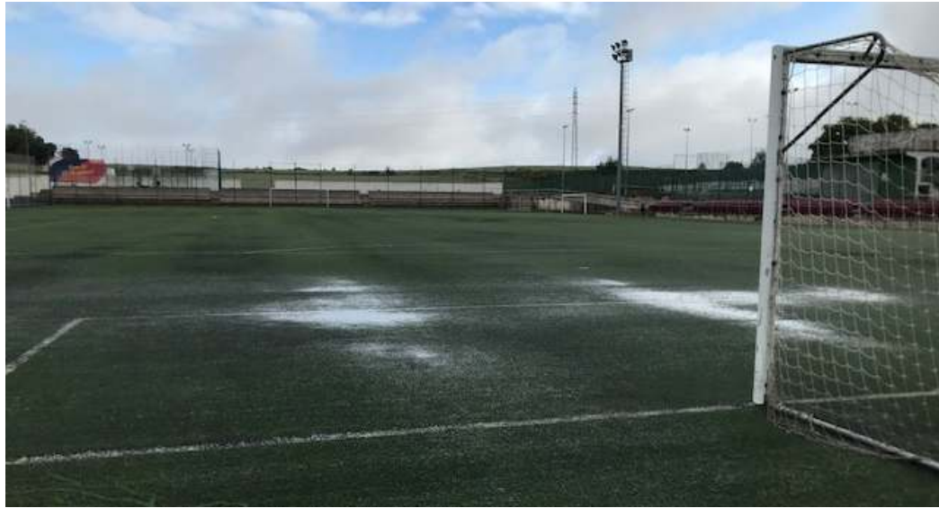
Vista del fons sud on es produeixen entollaments per defectes de planimetria
