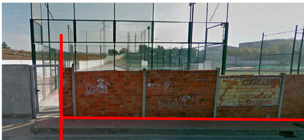
PUNT D'INICI DE L'ENDERROC
